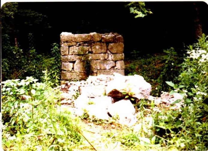
Destruction de un pilier à Moulin Buttress, Knoxville, Tennessee 22 juin, 1979
